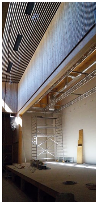
Die Theaterbühne im Saal Solstein ist bereits gut erkennbar, die letzten Arbeiten werden in den kommenden Wochen abgeschlossen.
